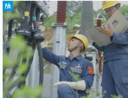
深圳供电局输电管理所电缆运维人员对线路进行接地环流测量，确保党的二十大期间线路安全稳定运行。
