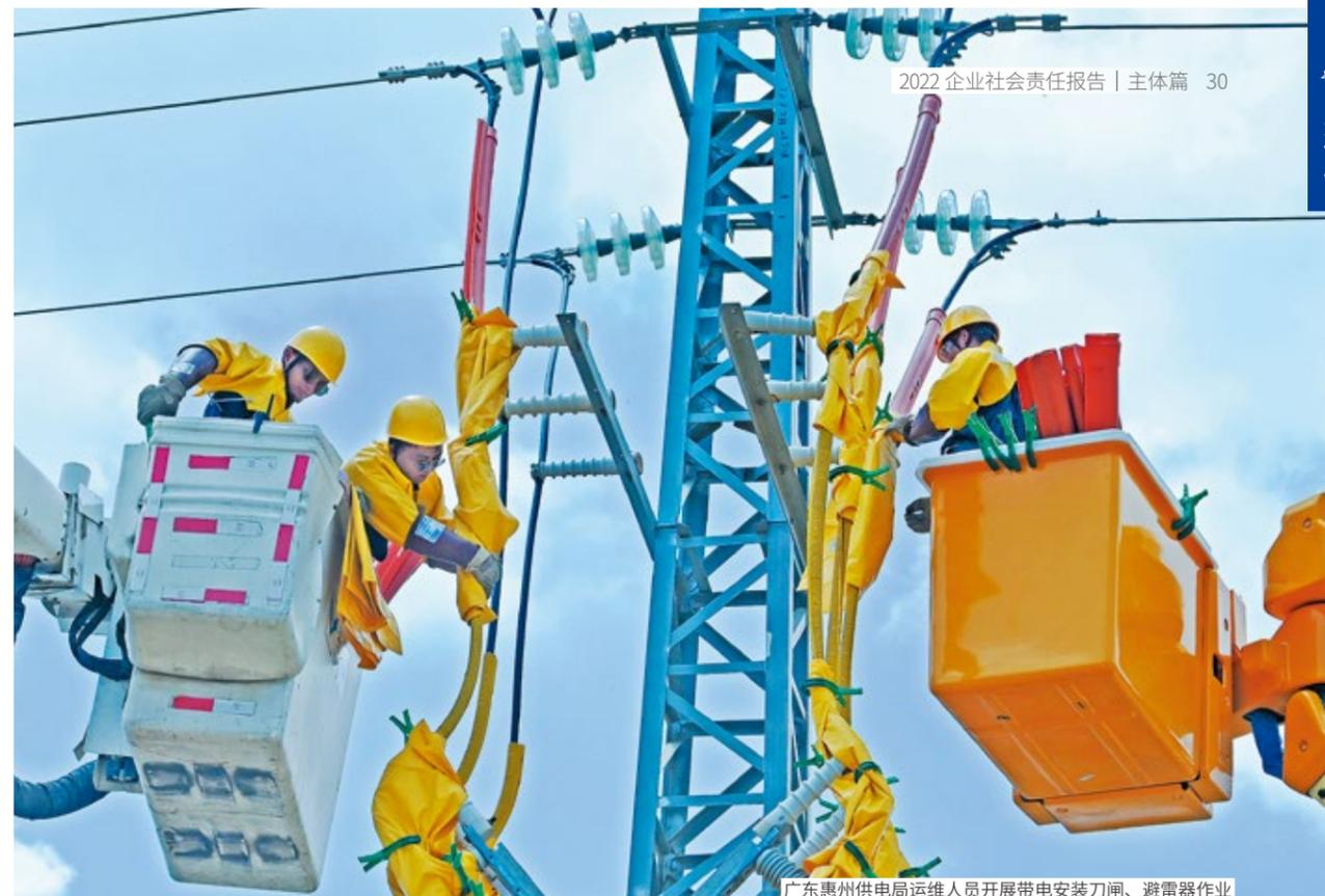
广东惠州供电局运维人员开展带电安装刀闸、避雷器作业
